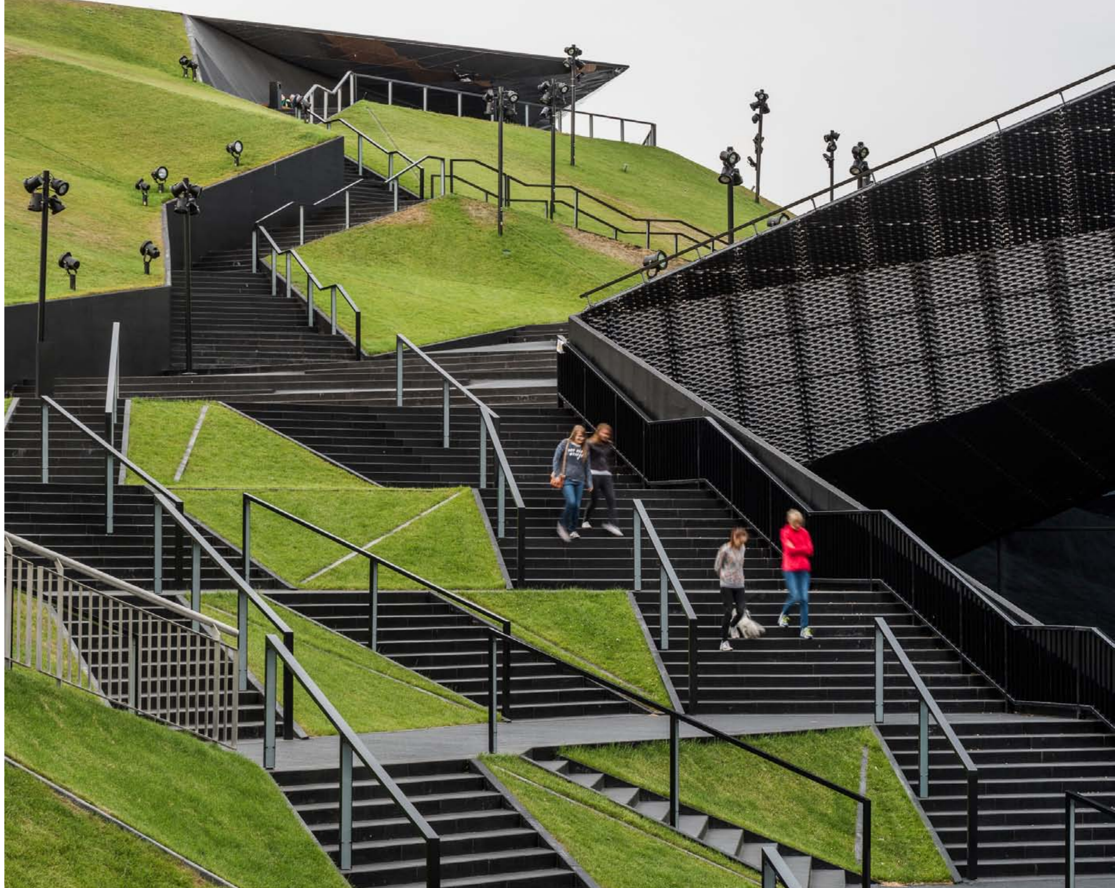
Fot. materiały pracowni architektonicznej, Bartek Barczyk
